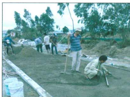
Hình 3: Vữa xi măng đệm được rải đều và san phẳng
