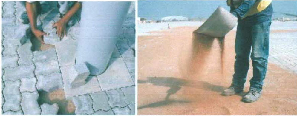
Hình 7: Gạch được cắt khớp Hình 8: Rải cát đều khắp bề mặt với chu vi hộp kỹ thuật
