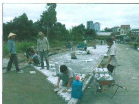
Hình 5: Gạch được xếp bằng thủ công hoặc cơ giới
