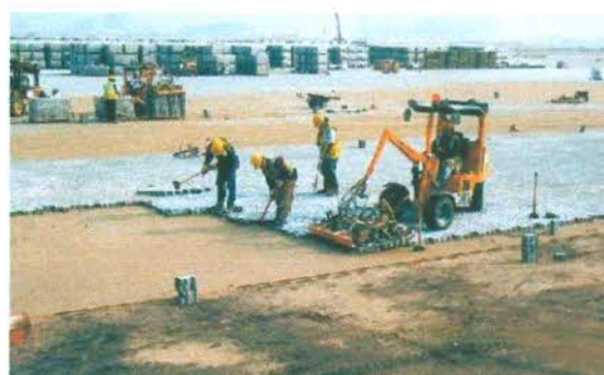
Hình 5: Gạch được xếp bằng thủ công hoặc cơ giới
