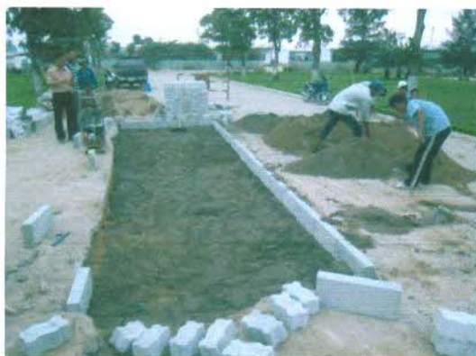
Hình 3: Vữa xi măng đệm được rải đều và san phẳng
