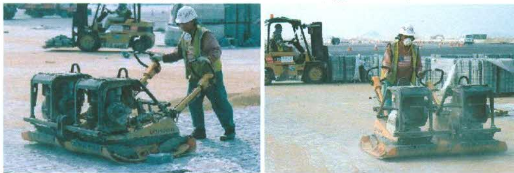
Hình 9: Đầm nén trước khi rải cát và sau khi rải cát
